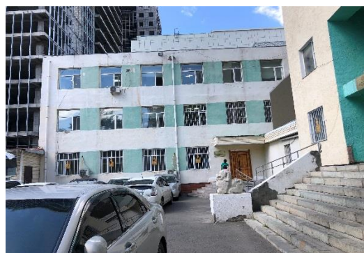
Барилга зүүн урд талдаа хоолойгоор холбогдсон
